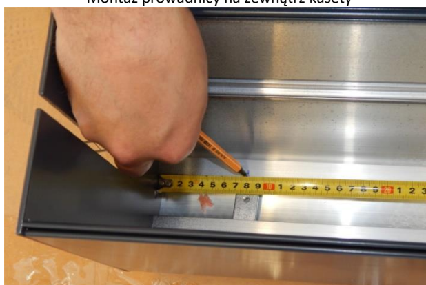
Montaż przewodnic na zewnątrz kasety
